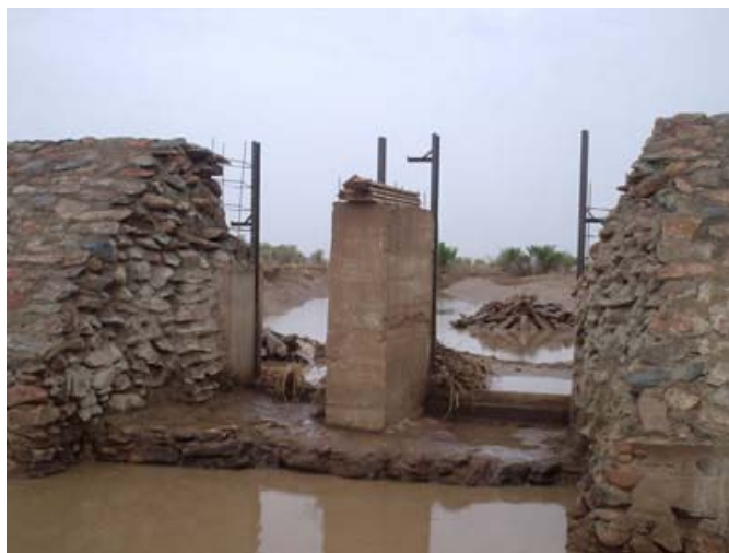
Le barrage de Tichy Ambidedy en construction (financement FSP Codéveloppement Mali et migrants)
