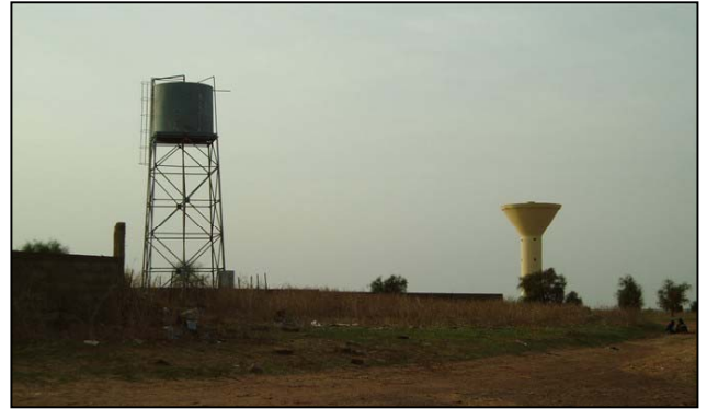
L'adduction d'eau de Kersignané : la première AEP du cercle de Yélimané réalisée par des migrants (1989), réhabilitée en béton en 2003.
